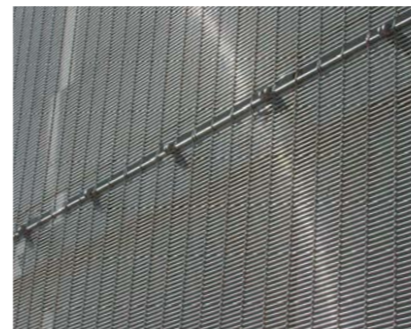
▲ ARTOS sigma: engmaschiges Gewebe, perfekt als Fassadenverkleidung
